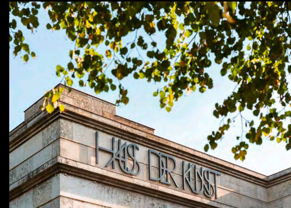
Das Haus der Kunst wartet seit Jahren auf eine Generalsanierung.
